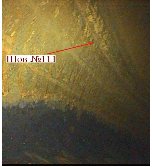
Рис.7 Шов приварки главного циркуляционного трубопровода к коллектору парогенератора (шов №111).
